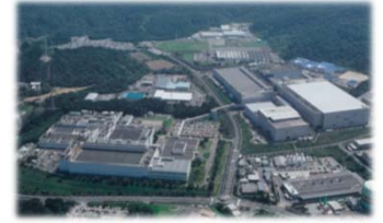
長崎テクノロジーセンター
